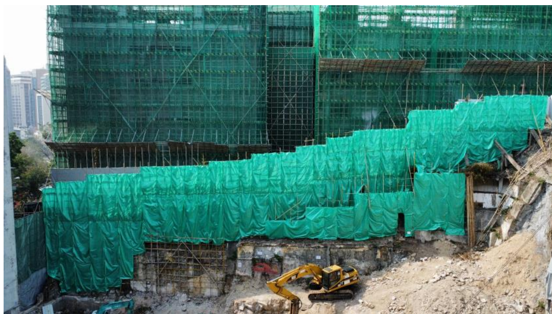
Figura 7 Colocação de andaimes duplos na fachada da antiga muralha de Macau nos estaleiros privados
