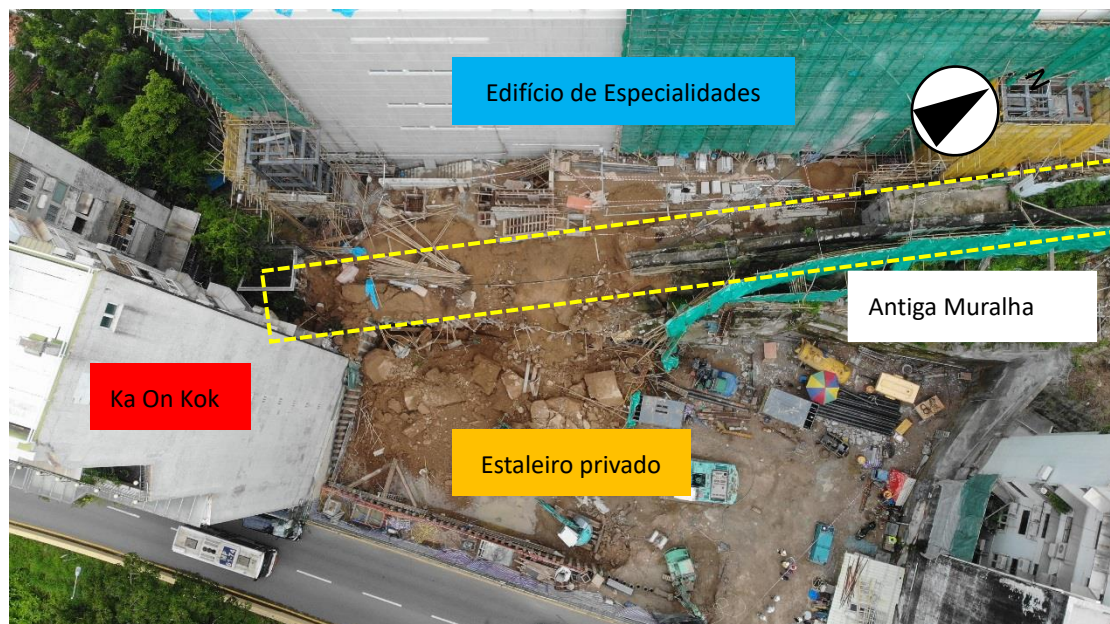
Figura 1 Vista do topo da muralha em ruínas
