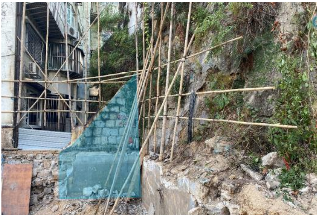
Figura 6. Remoção do murete baixo de reforço triangular que invadiu a área de construção privada
