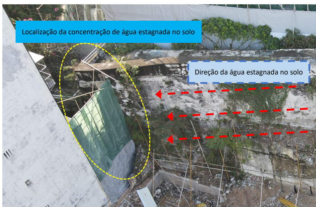
Figura 4 - Orientação geral dos fluxos de chuva que desaguam no interior do corredor turístico, na área de construção do Edifício de Especialidades (1)
