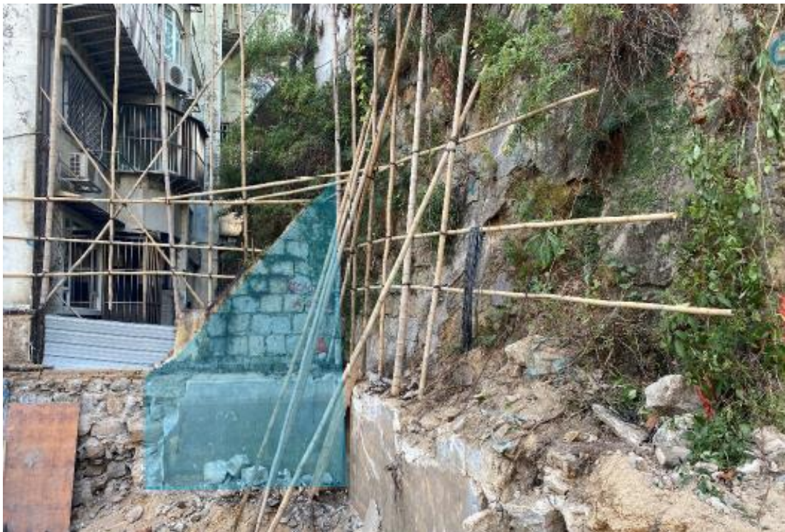
圖 6 私人地盤內拆除了侵入地界的三角矮牆
