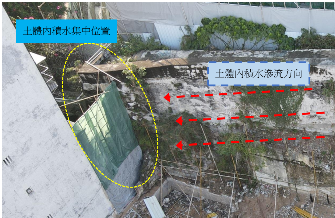
圖 4 專科大樓觀光走廊施工範圍內降雨入滲土體內的滲流方向示意圖(1)
