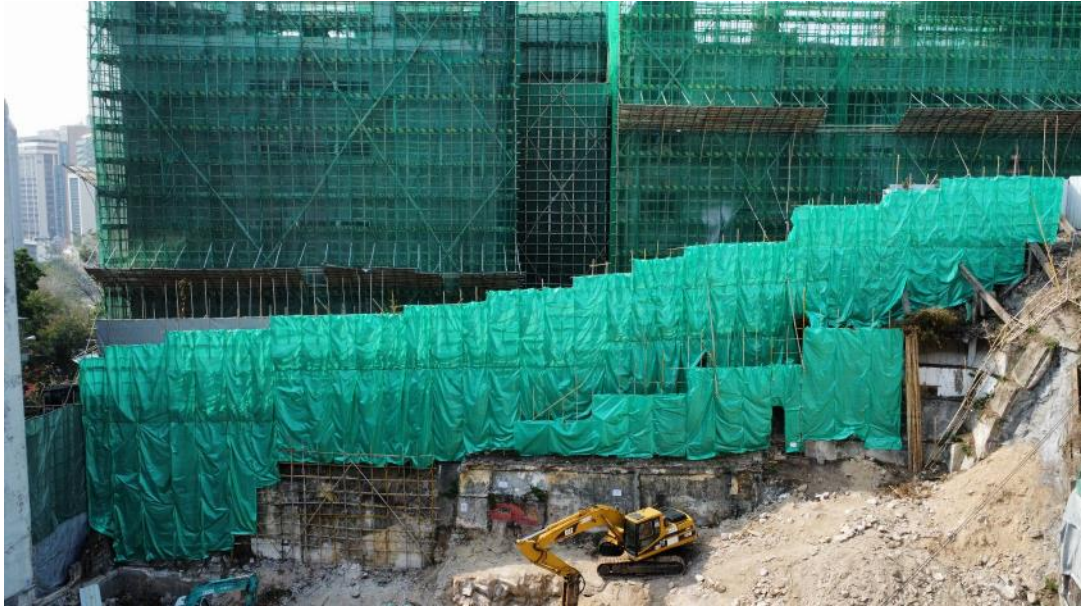
圖 7 私人地盤內在古城牆表面架設雙層棚架
