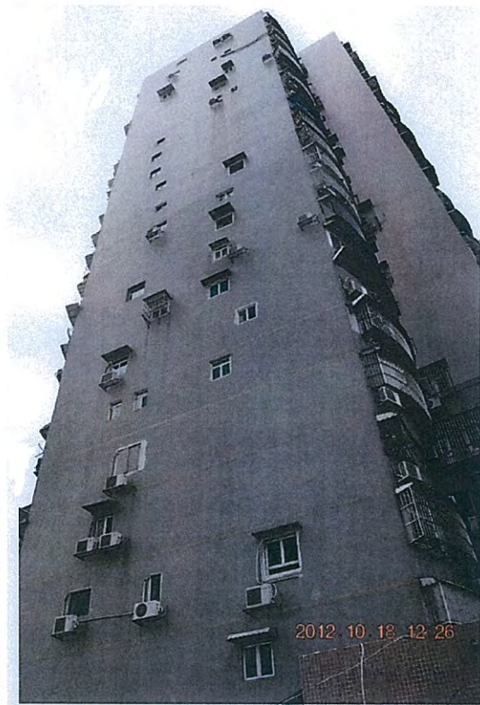
圖 10、P3 剪力牆開洞情況
