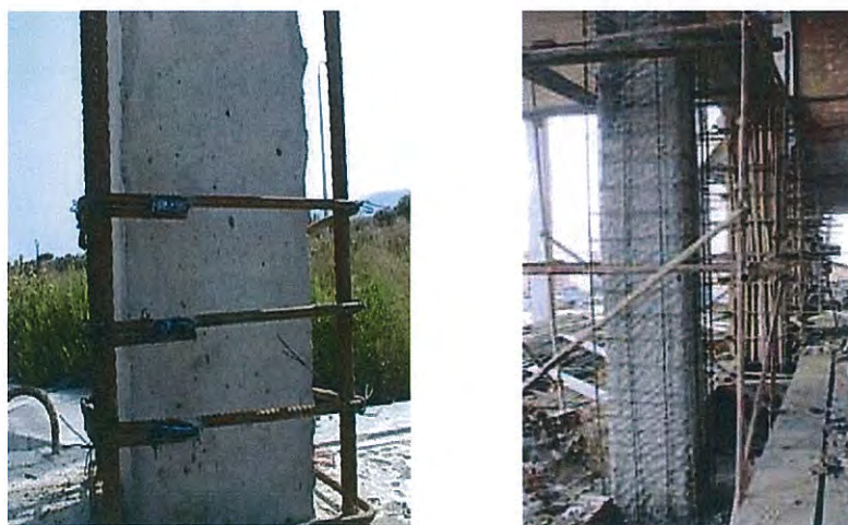
圖 20、鋼筋混凝土柱增大截面法加固圖
