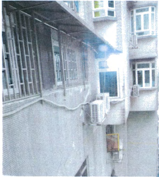
圖 11、大廈十三樓 D 單位對出平臺磚砌及金屬建構物
